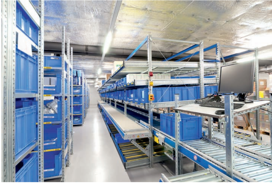
Bild 3: Das Durchlaufregal grenzt direkt an die Behälter-Fördertechnik
